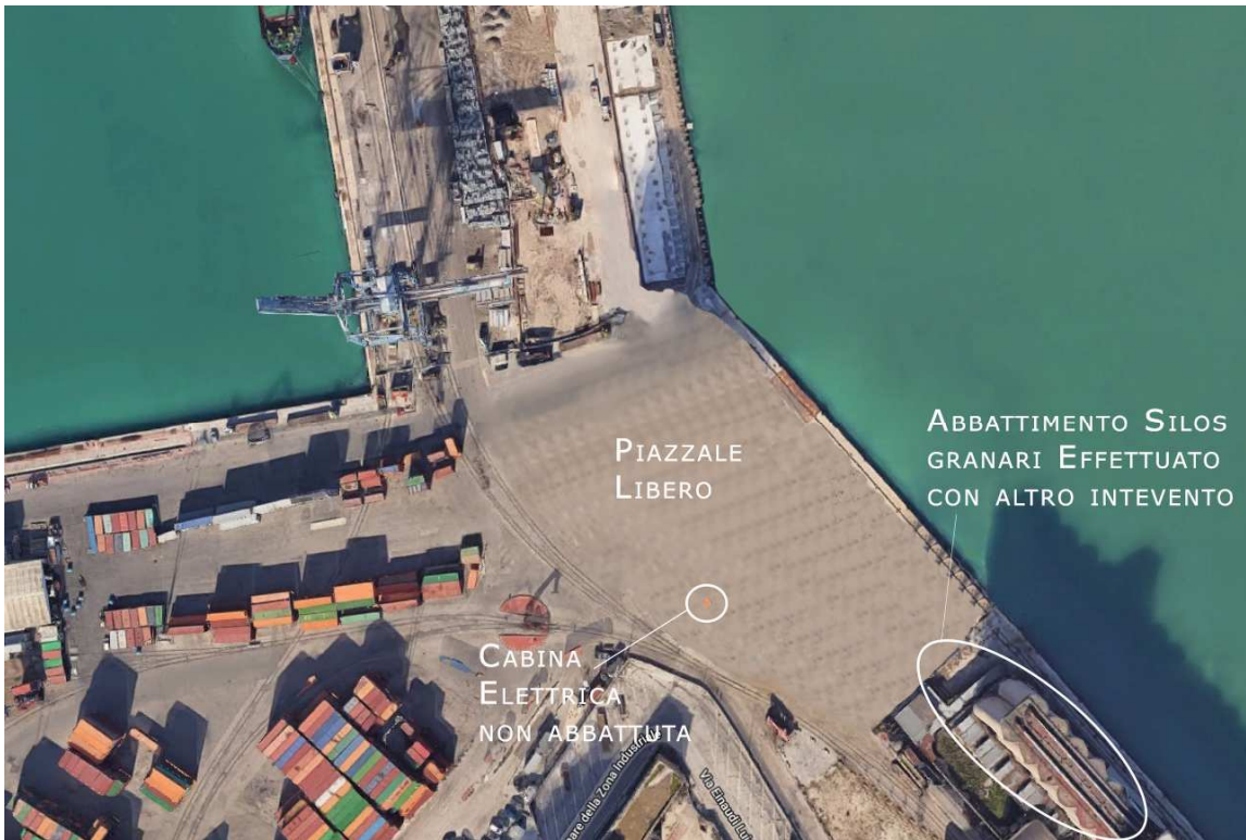
Figura 3 Nuova situazione Banchina 21 dopo l'abbattimento silos SAI Spa post operam
