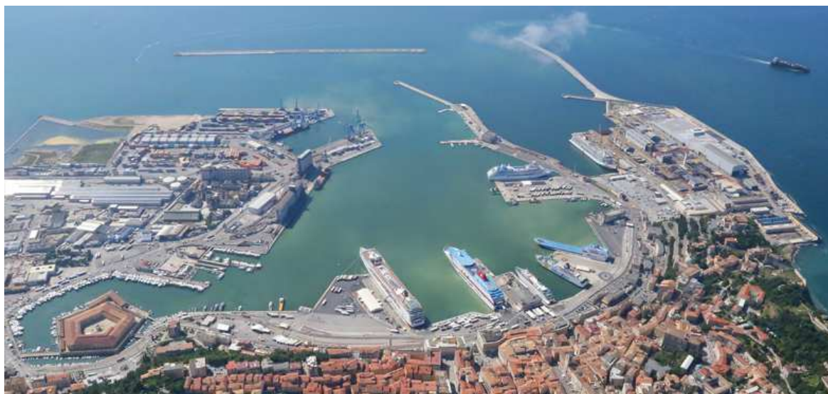
Figura 1 | Vista dall'alto del porto di Ancona
